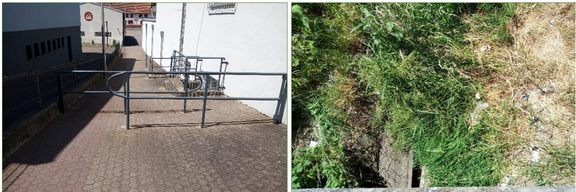
Abbildung 10 und 11: Fußweg im Westen und verrohrter Lauterbach (Quelle: ARGUS CONCEPT GmbH)
