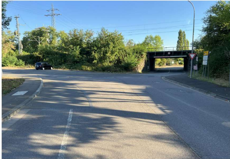
Abb. 5: Knotenpunkt L271 Saarbrücker Straße / Am Holzplatz aus Richtung Straße „Am Holzplatz“
