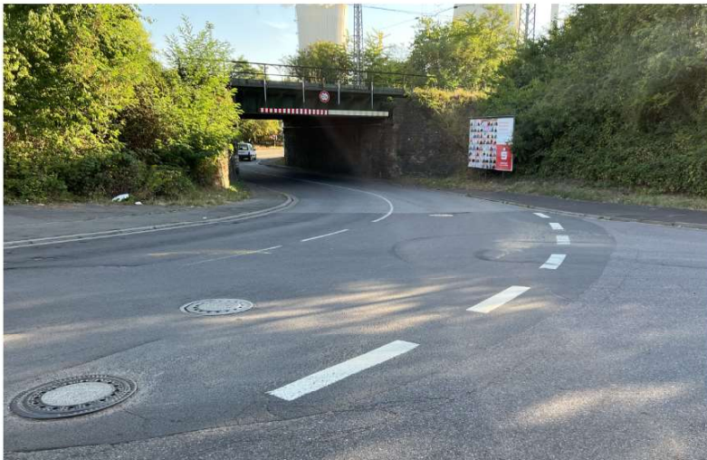
Abb. 4: L271 Saarbrücker Straße in Fahrtrichtung Fenne mit Bahnbrücke und 3,70 m Durchfahrtshöhe.
