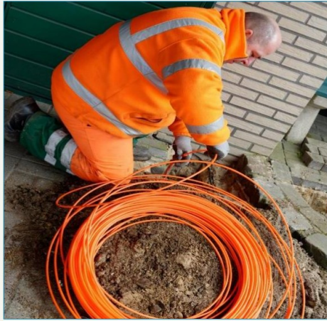
Aushub vor der Hauswand
