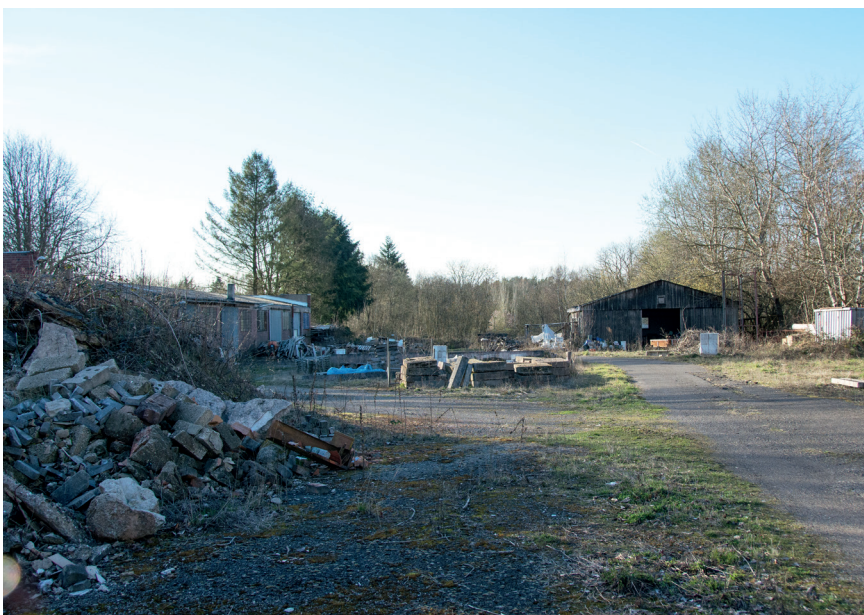
Blick auf das Plangebiet aus Richtung Süden
