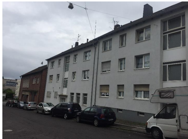
Bild: Alte Fahrzeughalle und Wohngebäude – Ansicht Fontanestraße
