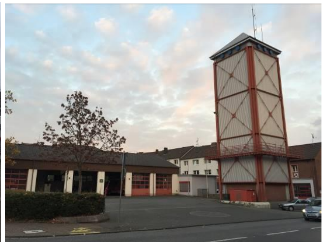
Bild: Neue Fahrzeughalle und Schlauchturm – Danziger Straße
