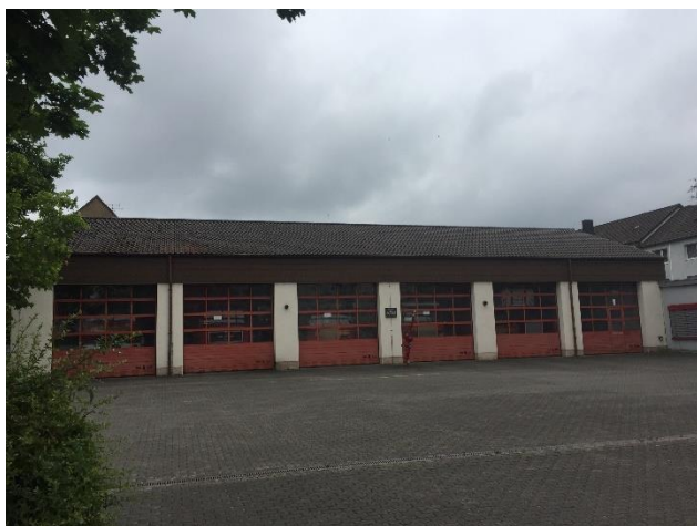
Bild: Neue Fahrzeughalle – Danziger Straße
