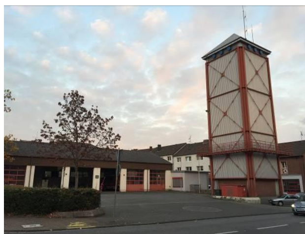
Bild: Neue Fahrzeughalle und Schlauchturm – Danziger Straße
