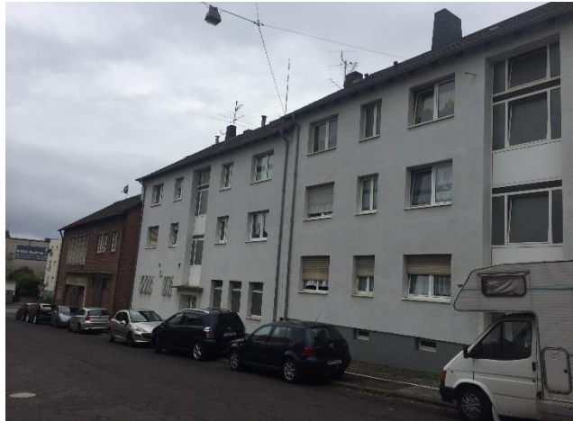
Bild: Alte Fahrzeughalle und Wohngebäude – Ansicht Fontanestraße
