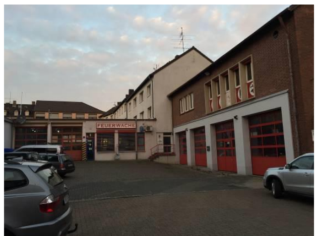
Bild: Werkstatt- u. Lagertrakt und alte Fahrzeughalle, Danziger Straße
