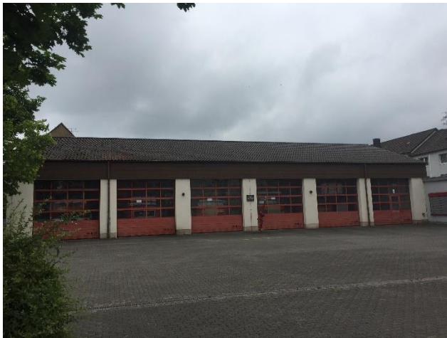
Bild: Neue Fahrzeughalle – Danziger Straße
