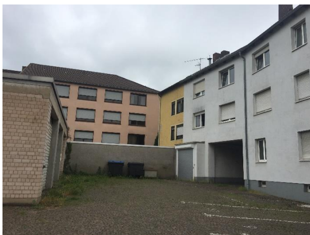
Bild: Innenhof mit Garagenanlage DRK und Wohngebäude
