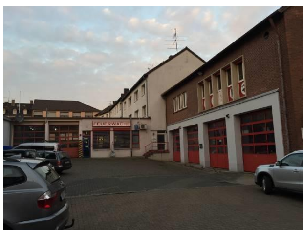
Bild: Werkstatt- u. Lagertrakt und alte Fahrzeughalle, Danziger Straße
