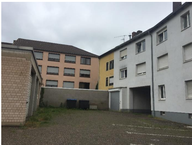
Bild: Innenhof mit Garagenanlage DRK und Wohngebäude
