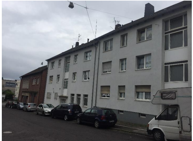
Bild: Alte Fahrzeughalle und Wohngebäude – Ansicht Fontanestraße
