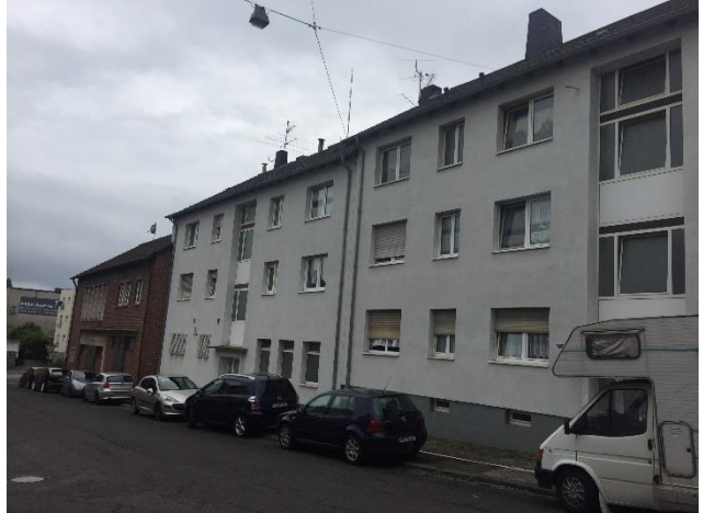
Bild: Alte Fahrzeughalle und Wohngebäude – Ansicht Fontanestraße
