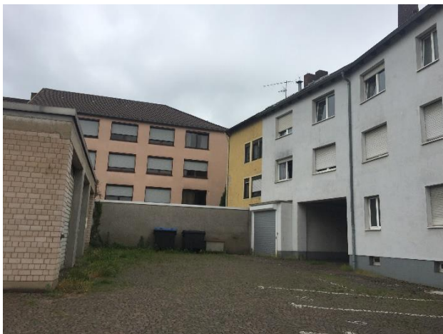
Bild: Innenhof mit Garagenanlage DRK und Wohngebäude
