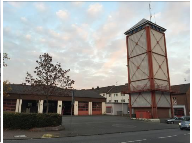
Bild: Neue Fahrzeughalle und Schlauchturm – Danziger Straße
