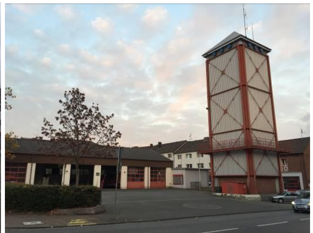
Bild: Neue Fahrzeughalle und Schlauchturm – Danziger Straße
