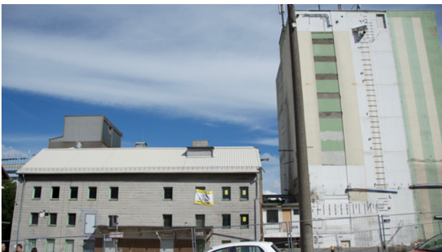
Bestandsgebäude ehem. Quirin-Mühle
