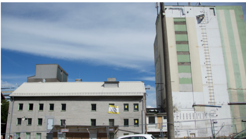
Bestandsgebäude ehem. Quirin-Mühle
