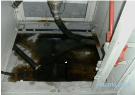
Keller: Traforaum, gekapptes KV-Kabel mit Öfüllung
